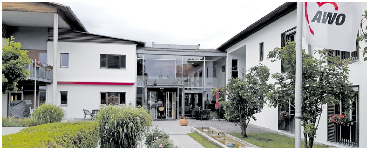
Große Glasflächen im Eingangsbereich führen dort zu starker Aufheizung. Geplant sind Begrünungen, Sonnenschutz-elemente und Verschattung durch Bäume.
